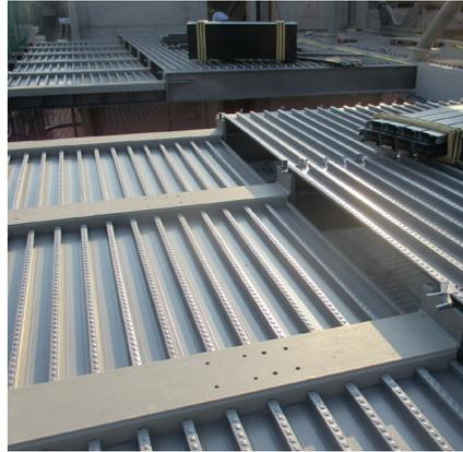
anschlüsse mit einer neu entwickelten Brandschutzlösung zum Einsatz. Diese beinhaltet das Verfüllen der offenen Schwalbenschwänze mit einem schnell und einfach zu installierenden Brandschutzsickenfüller der Firma Hilti, der zudem auch die Schallschutzanforderungen erfüllt. So aufgebaut erreichen die entsprechenden Deckenanschlüsse die Feuerwiderstandsklasse EI 90. Damit halten sie dem Feuer im Brandfall
